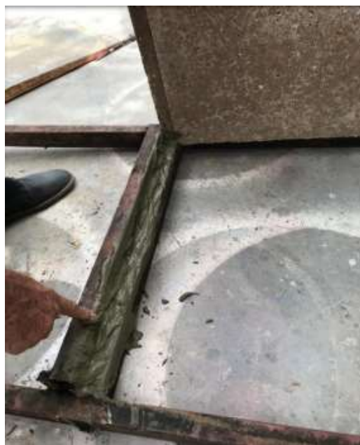
Fig. 10 Pasta de cemento en los bordes de apoyo Fuente: (Ciriano Marante, 2019)
