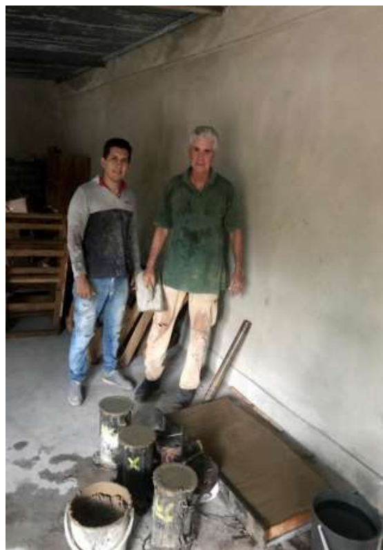
Fig 8: Ejecutores junto a la losa terminada Fuente (Ciriano Marante, 2019)
