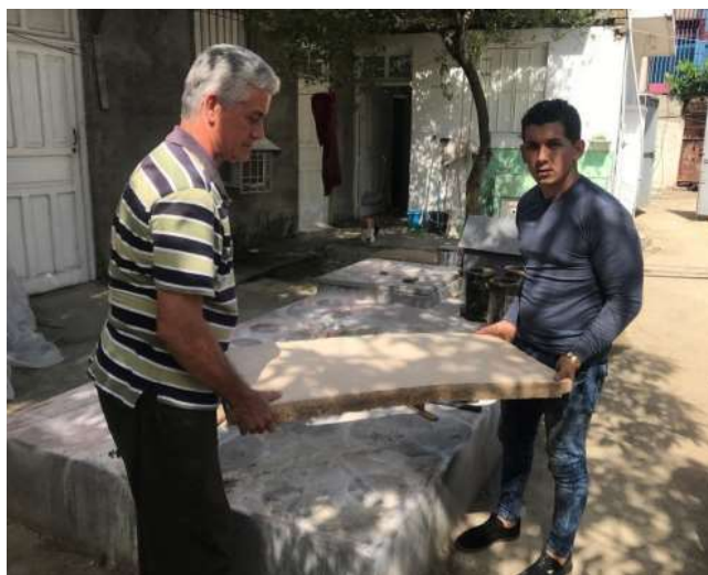
Fig. 9: Proceso de traslado y colocación de la losa Fuente: (Ciriano Marante, 2019)
